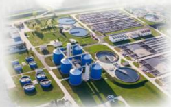
Tratamiento de aguas
